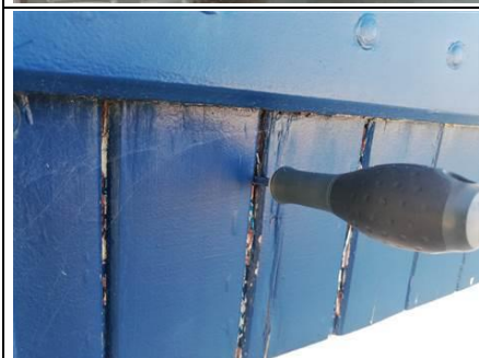
Photo n° PhTer0002 Localisation : Cuisine Ouvrage : Volet battant 1 - Bois et Peinture Parasite : Présence d'indices d'infestation d'autres agents de dégradation biologique du bois
