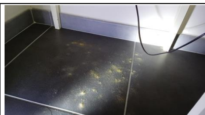
Photo n° PhTer001 Localisation : Rez de chaussée - Chambre 2 Ouvrage : Meuble (s) - Bois Parasite : ---- Insectes à larves xylophages ----
