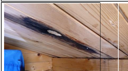
Photo n° PhTer003 Localisation : Bâtiment (s) Annexe (s) - Abri de jardin Ouvrage : Plafond - Lambris Bois Parasite : --- Champignons lignivores --
