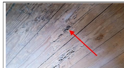
Photo n° PhTer001 Localisation : Sous-Sol - Cave Ouvrage : Plafond - Charpente : Pannes Bois et Plancher bois Parasite : Présence d'indices d'infestation de termites, ---- Insectes à larves xylophages ----
