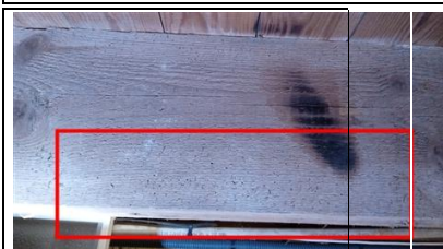
Photo n° PhTer002 Localisation : Sous-Sol - Cave Ouvrage : Plafond - Charpente : Pannes Bois et Plancher bois Parasite : Présence d'indices d'infestation de termites, ---- Insectes à larves xylophages ----
