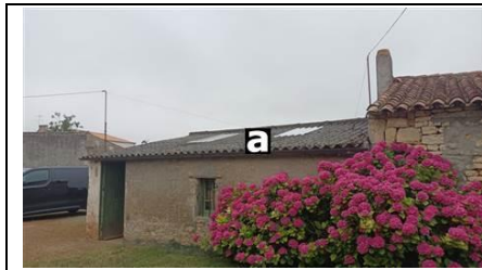
Photo n° PhA001 Localisation : atelier Ouvrage : Plaques ondulées Partie d'ouvrage : Plaques en fibres-ciment Description : Plaques en fibres-ciment
