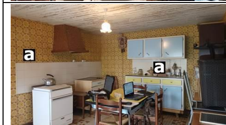
Photo n° PhA002 Localisation : Cuisine; degagement; piece 1; piece 2 Ouvrage : Murs et cloisons Partie d'ouvrage : Revêtements durs (plaques planes fibres-ciment) Description : Revêtements durs (plaques planes fibres-ciment)
