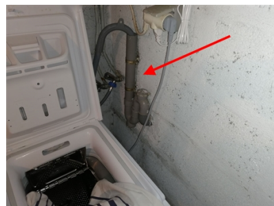
Photo n° PhAss003 Localisation : Eau Usée : Buanderie Description : Lave-Linge : Rejet non retrouvé
