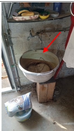
Photo n° PhAss002 Localisation : Eau Usée : Garage Description : Evier : Rejet par épandage
