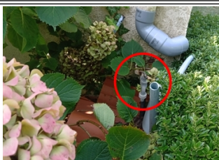
Photo n° PhAss004 Localisation : Eau Usée : Extérieur Description : Robinet de puisage : Rejet non retrouvé
