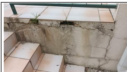
Photo n° PhTer002 Localisation : TERRASSE Informations complémentaires : fissures terrasse extérieur
