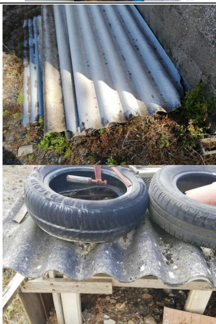
Dépôt de plaques en fibro ciment contenant de l'amiante
