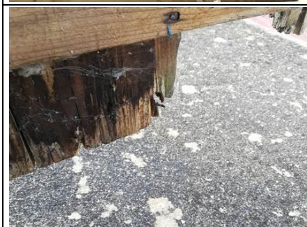
Photo n° PhTer0002 Localisation : Maison principale - Grenier Ouvrage : Porte extérieure - Bois et Peinture Parasite : Présence d'indices d'infestation d'autres agents de dégradation biologique du bois
