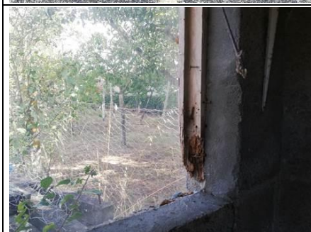
Photo n° PhTer0003 Localisation : Dépendances - Remise 4 Ouvrage : Fenêtre - Bois Parasite : Présence d'indices d'infestation d'autres agents de dégradation biologique du bois
