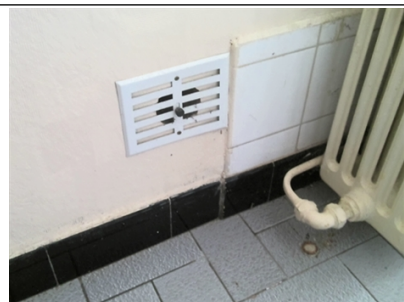
Photo n° PhGaz002 19.8 : le dispositif de l'amenée d'air du local équipé ou prévu pour un appareil d'utilisation est obturable. (Rez de chaussée - Cuisine) Présence d'un grille d'amenée d'air obturable; Remplacer la grille d'amenée d'air obturable par une grille d'amenée d'air non obturable
