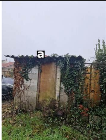
Photo n° PhA002 Localisation : petit toit Ouvrage : Plaques ondulées Partie d'ouvrage : Plaques en fibres-ciment Description : Plaques en fibres-ciment
