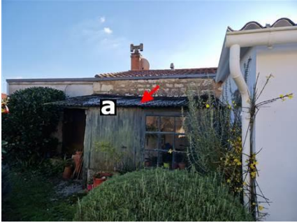
Photo n° PhA001 Localisation : Abri de jardin; Garage Ouvrage : Plaques ondulées Partie d'ouvrage : Plaques en fibres-ciment Description : Plaques en fibres-ciment
