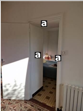
Photo n° PhA002 Localisation : bureau; Chambre 1 Ouvrage : Murs et cloisons Partie d'ouvrage : Revêtements durs (plaques planes fibres-ciment) Description : Revêtements durs (plaques planes fibres-ciment)
