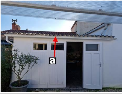
Photo n° PhA001 Localisation : Abri de jardin; Garage Ouvrage : Plaques ondulées Partie d'ouvrage : Plaques en fibres-ciment Description : Plaques en fibres-ciment
