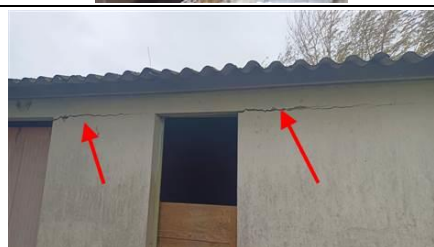
Photo n° PhTer002 Localisation : maison Ouvrage : présence de fissure sur l'ensemble du bati Informations complémentaires : présence de fissures et d'humidité sur la maison
