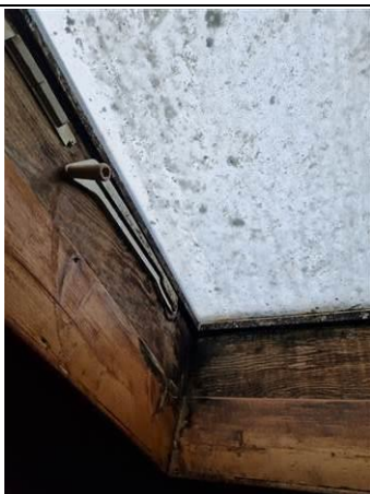
Photo n° PhTer003 Localisation : velux grenier Ouvrage : bois fenetre
