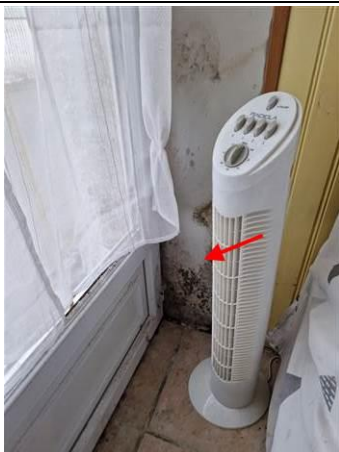
Photo n° PhTer004 Localisation : cuisine Ouvrage : embrassade de porte
