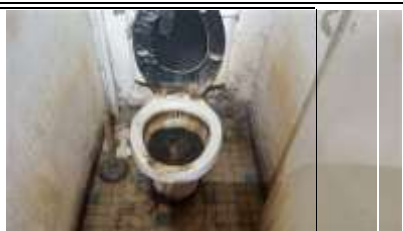
Photo n° PhAss004 Localisation : Eau Usée : Wc 2 Description : WC : Bouché (Contrôle impossible)
