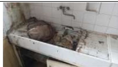
Photo n° PhAss003 Localisation : Eau Usée : Arrière Cuisine Description : Evier : Non raccordé
