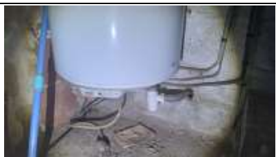
Photo n° PhAss002 Localisation : Eau Usée : Garage Description : Ballon d'eau chaude : Rejet par épandage
