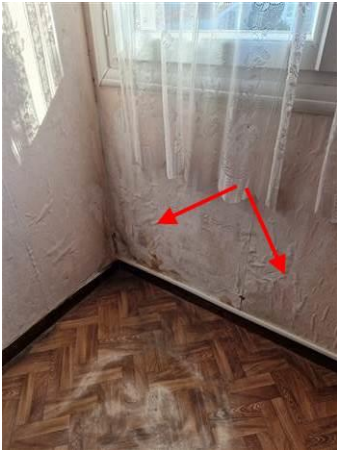
Photo n° PhTer002 Localisation : Séjour; Salon; Chambre 2 Ouvrage : Murs Informations complémentaires : Présence d'humidité sur bas de murs , voir avec un professionnel qualifié
