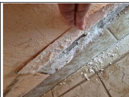
Photo n° PhTer004 Localisation : Séjour; Salon; Chambre 2 Ouvrage : Murs Informations complémentaires : Présence d'humidité sur bas de murs , voir avec un professionnel qualifié
