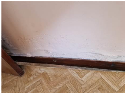
Photo n° PhTer002 Localisation : Séjour; Salon; Chambre 2 Ouvrage : Murs Informations complémentaires : Présence d'humidité sur bas de murs , voir avec un professionnel qualifié
