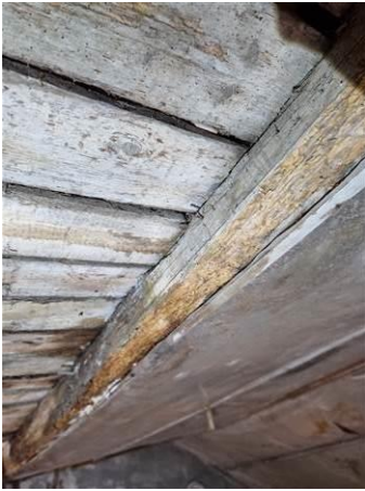
Photo n° PhTer001 Localisation : Grange 1; Grange 2; Grange 3; toit cochon; appenti ferme Ouvrage : CHARPENTE BOIS ET BATIMENT FORTEMENT DEGRADE Parasite : ---- Insectes à larves xylophages ----, Anobium punctatum (Petites vrillettes), Capricornes des maisons ( Hylotrupes bajulus ) Indices : altérations dans le bois (élément(s) fortement dégradé(s))
