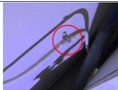
Photo n° PhGaz003 11a : au moins un appareil est raccordé en gaz avec un tube souple. Le matériel n'est pas autorisé; Faire intervenir un installateur gaz qualifié afin de remplacer le matériel existant par du matériel autorisé
