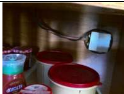
Photo n° PhGaz002 8a1 : au moins un organe de coupure d'appareil est absent. (Rez de chaussée - Cuisine) Absence de robinet de commande; Faire intervenir un installateur gaz qualifié afin d'installer un robinet de commande
