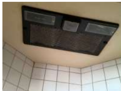
Photo n° PhGaz005 20.7 : la sortie d'air du local équipé ou prévu pour un appareil d'utilisation est constituée par un dispositif de ventilation mécanique (hotte avec ventilateur d'extraction intégré ou non) ne répondant pas aux critères d'installation. (Rez de chaussée - Cuisine) Présence d'une sortie d'air assurée uniquement par une hotte avec ventilateur d'extraction (intégré ou non) ne répondant pas aux critères d'installation; supprimer la hotte ou créer une autre sortie d'air permanente, directe ou indirecte
