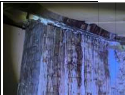
Photo n° PhTer001 Localisation : 1er étage - Grenier 1 Ouvrage : Plafond - Charpente: Entrails, Arbalétriers, Poinçons, Contrefiches, Pannes, Chevrons, Volige : Bois Parasite : ---- Insectes à larves xylophages ----, --- Champignons lignivores --- Informations complémentaires : Présence d'une fuite d'eau ancienne ou non au niveau de la cheminée
