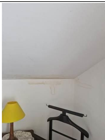
Photo n° PhTer001 Localisation : chambre 1 Ouvrage : Taches humidité plafond
