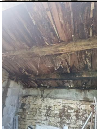
Photo n° PhTer002 Localisation : petit toit Ouvrage : Plafond - Bois et tuile Parasite : --- Champignons lignivores --- Indices : décoloration du bois, dégradation du bois (élément(s) fortement dégradé(s))
