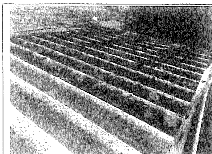
Photo n° PhA001 Localisation : Rez de chaussée - Salle d'eau/WC/Dégagement Ouvrage : Toitures Partie d'ouvrage : Plaques (fibres-ciment) Description : Plaques (fibres-ciment)
