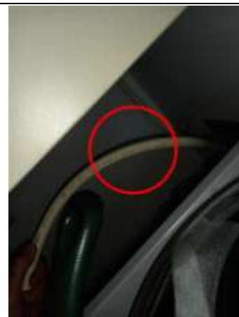
Photo n° PhGaz002 14 : la date limite d'utilisation du tuyau d'alimentation n'est pas lisible ou est dépassée. La date limite d'utilisation des tuyaux non rigides sont dépassées; Faire intervenir un installateur gaz qualifié afin de remplacer le tuyau existant par un tuyau neuf
