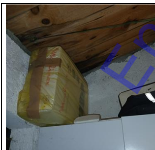
Photo n° PhTer001 Localisation : Rez de chaussée - Garage Ouvrage : Plafond - Charpente : Pannes, Chevrons, Volige : Bois Informations complémentaires : Présence de fuite(s) d'eau dans la toiture. (Ancienne trace)
