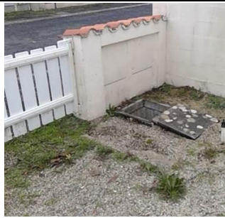
Photo n° PhAss001 Localisation : Eau Usée Description : Type de raccordement : Siphon disconnecteur
