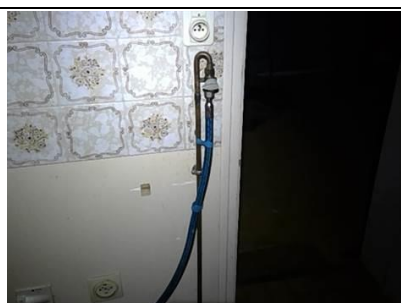
Photo n° PhGaz001 Localisation : Cuisine Robinet en attente (Type : Non raccordé)
