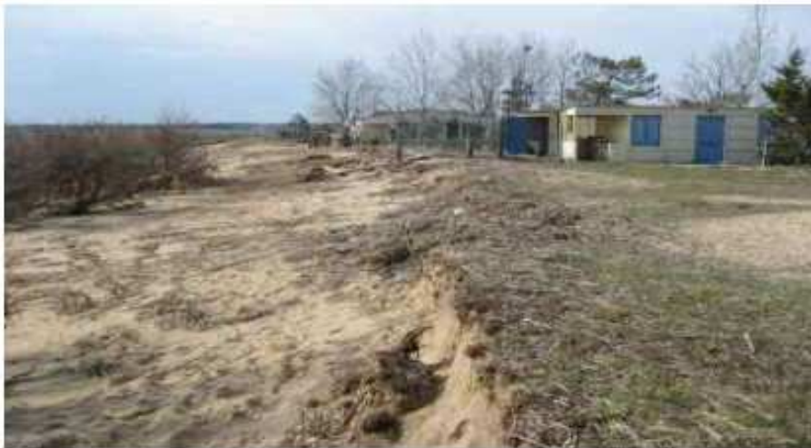
Affouillement côté marais et traces de surverse sur le cordon dunaire au lieu-dit « les Caves »
