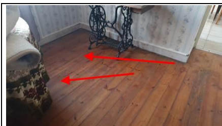
PHOTO N° PHTER001 LOCALISATION : CHAMBRE 1 OUVRAGE : PARQUET BOIS PARASITE : PRÉSENCE D'INDICES D'INFESTATION DE TERMITES INDICES : ALTÉRATIONS DANS LE BOIS, BOIS D'APPARENCE FEUILLETÉ, DÉGRADATION DU BOIS INFORMATIONS COMPLÉMENTAIRES : PARQUET BOIS COTÉ RUE FORTEMENT DÉGRADÉS
