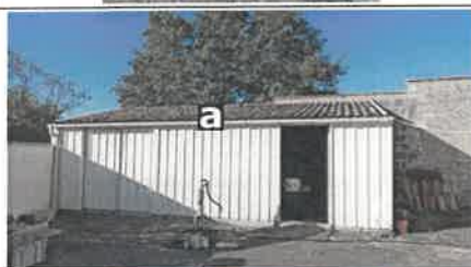
Photo n° PhA002 Localisation : Garage 2 Ouvrage : Plaques ondulées Partie d'ouvrage : Plaques en fibres-ciment Description : Plaques en fibres-ciment
